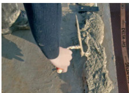
Appliquer le lit de mortier
