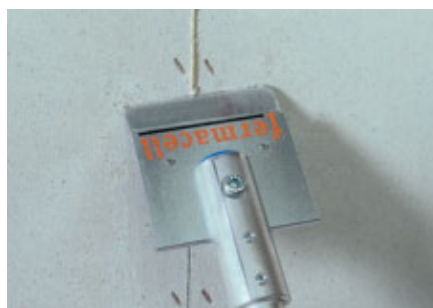
Élimination de la colle excédentaire à l'aide du Couteau à colle spécial fermacell
