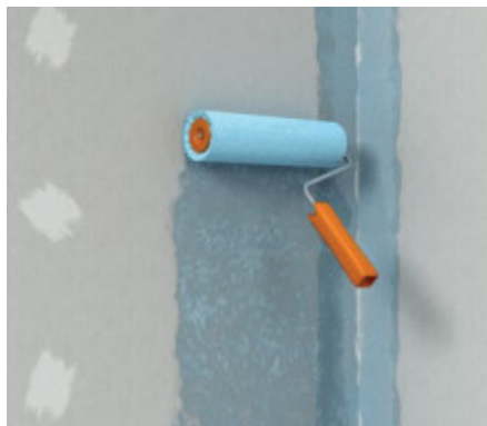
Illu. 1 : Appliquer Couche de fond fermacell sur l'ensemble de la surface.
