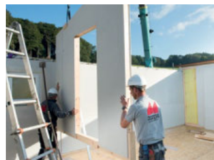
Montage sur le chantier
