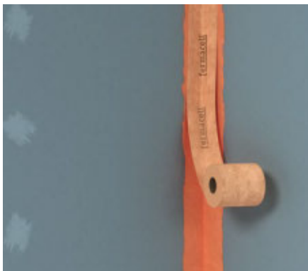
Illu. 2 : Comprimer la Bande d'étanchéité fermacell dans la couche encore humide de sous-couche de protection à l'eau préalablement appliquée, puis réenduire d'une nouvelle sous-couche de protection
