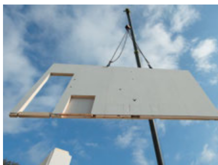
Transport par grue sur chantier
