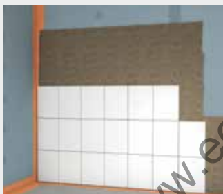
Fig. 22 : Utilisation de Plaque fermacell Powerpanel H 2 O en intérieur. Les carreaux sont posés sur une fine couche de Mortier-colle flexible fermacell (protégeant contre une taux d'humidité de classe A01).
