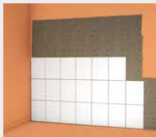
Fig. 24 : Les carreaux sont posés sur une fine couche de Mortier-colle flexible fermacell appliquée sur support étanche (protégeant contre une taux d'humidité de classe A).
