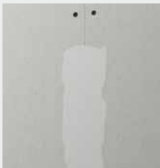
Joint collé et enduit
